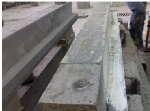
شکل ۶- نحوه تقویت یکی از تیرها با ورق GFRP
