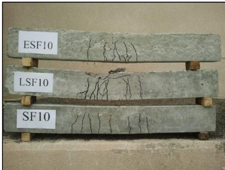
شکل ۸- مقایسه نحوه ترک خوردگی تیرها و خیز آنها در زمان گسیختگی
