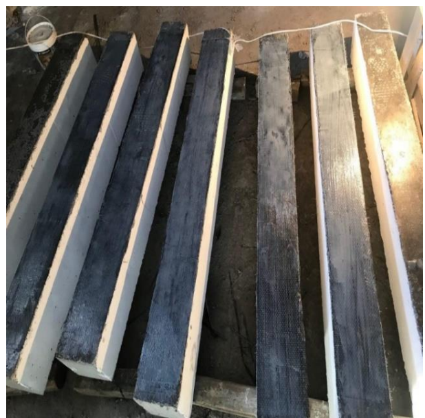
شکل ۶- چسباندن ورق CFRP به تیرهای بتنی
