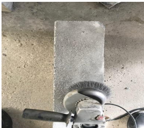
شکل ۴- آماده‌سازی سطح بتن قبل از چسباندن ورق CFRP با روش دستگاه فرز
