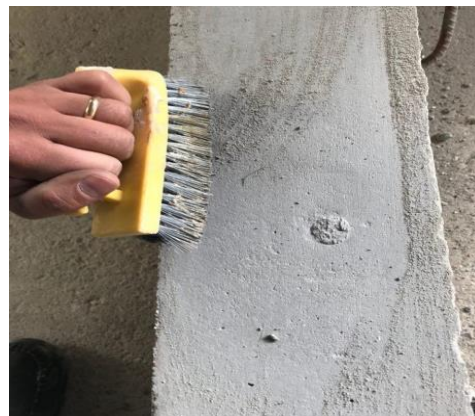
شکل ۳- آماده‌سازی سطح بتن قبل از چسباندن ورق CFRP با روش برس سیمی
