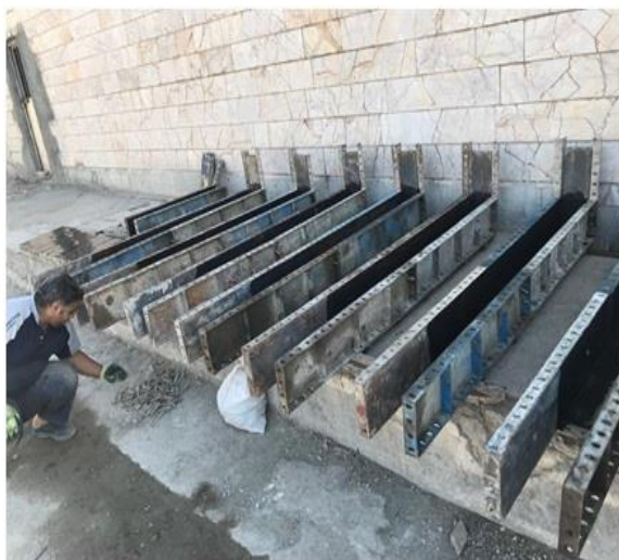
شکل ۱- آرماتوربندی و قالب‌بندی تیرهای بتنی
