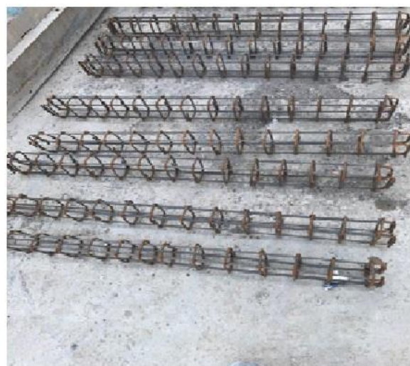
شکل ۱- آرماتوربندی و قالب‌بندی تیرهای بتنی
