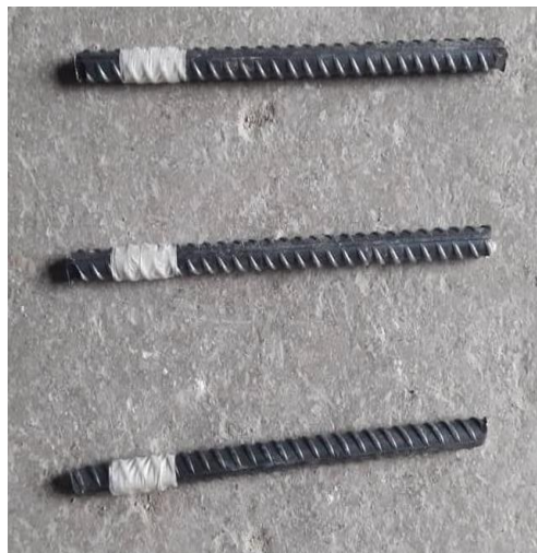
شکل ۳- آماده سازی میلگردها برای جاگذاری در بتن
