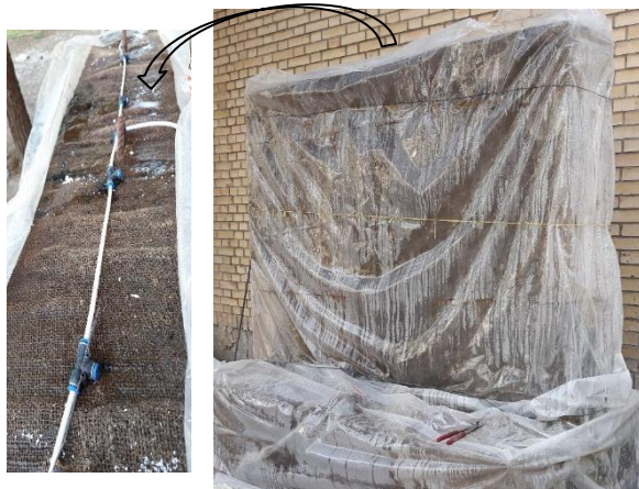
شکل ۶- عمل آوری دیوار بتنی
