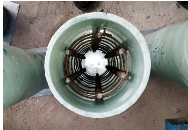
شکل ۴- نحوه قرارگیری قفسه میلگردها درون غلاف‌های GRP و قالب‌های PVC
