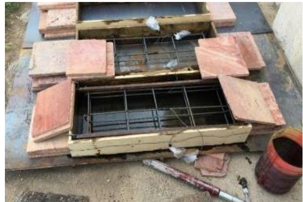
شکل ۶- آماده‌سازی و روغن زدن قالب‌های چوبی
