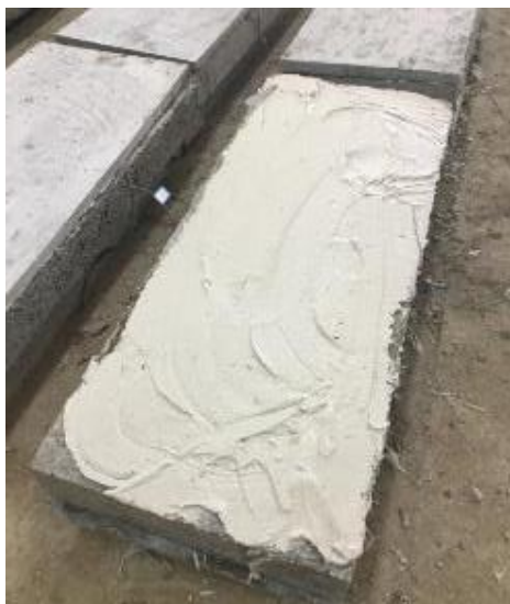
شکل ۹- آغشتن سطح دال به مخلوط چسب جهت چسباندن ورقه بتن توانمند الیافی
