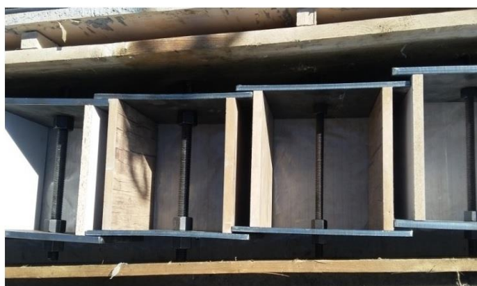
الف- آماده سازی نمونه‌ها قبل از بتن ریزی
