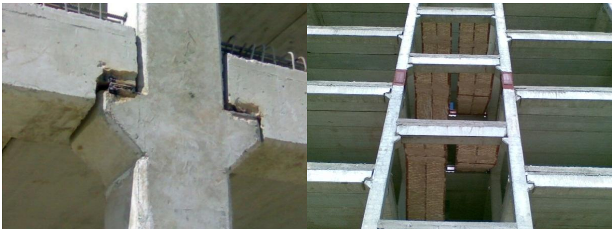
شکل ۱- اتصال تیر به ستون پیش ساخته رایج در ایران
