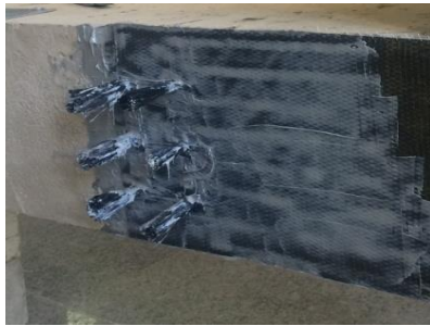
ج) نصب اولین لایه‌ی کامپوزیت CFRP
