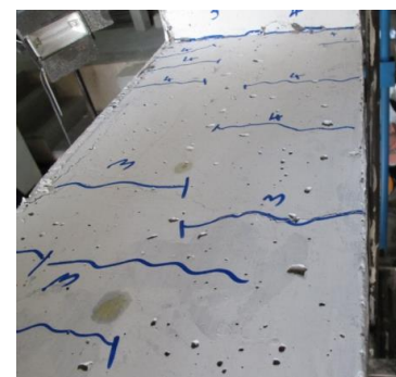
الف) ترک‌های ناحیه‌ی فوقانی تیر در قسمت تقویت شده در تغییر مکان جانبی نسبی 2/75\%
