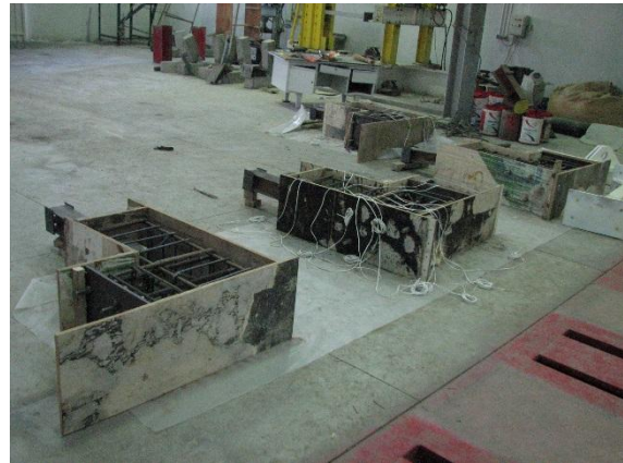
(الف) آرماتوربندی و قالب‌بندی
