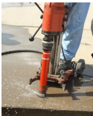
شکل ۴- مغزه‌گیری از دلفین و شمع با استفاده از دستگاه مغزه گیر
