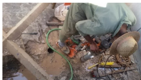
شکل ۴- مغزه‌گیری از دلفین و شمع با استفاده از دستگاه مغزه گیر
