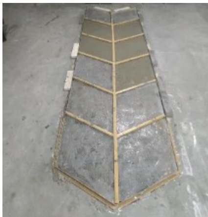
(ب) بتن ریزی در پارچه
