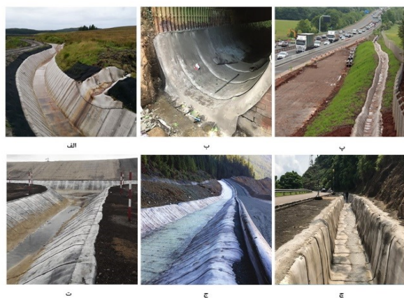
شکل ۲- اجرای لاینینگ کانال با بتن پارچه‌ای در جهان: الف) اسکاتلند، ب و پ) انگلستان، ت) روسیه، ج) کانادا چ) مالزی
