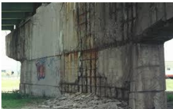
شکل ۲- اثرات خوردگی میلگرد در بتن پوشش سازه‌های بتن آرمه
