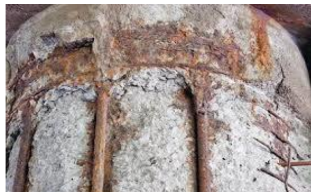
شکل ۲- اثرات خوردگی میلگرد در بتن پوشش سازه‌های بتن آرمه
