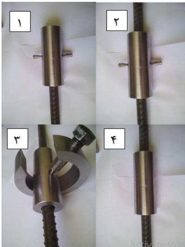
شکل ۳۰- مراحل اجرای وصله دو میلگرد به هم به روش غلاف و گوه.
