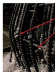
شکل ۵- کوپلر رزوه‌ای استاندارد برای وصله مکانیکی [۵]
