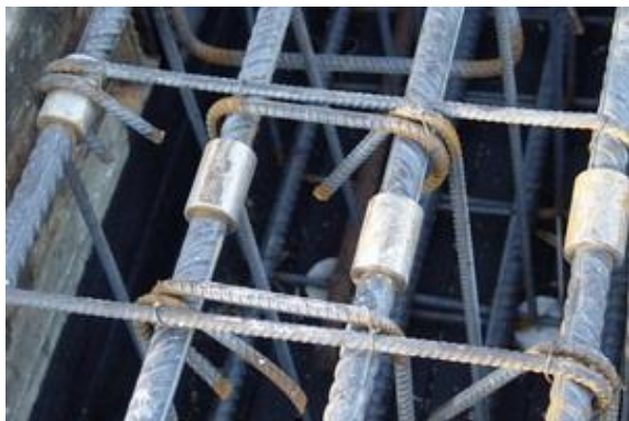
شکل ۴- وصله مکانیکی با کوپلر رزوه‌ای استاندارد [۴]
